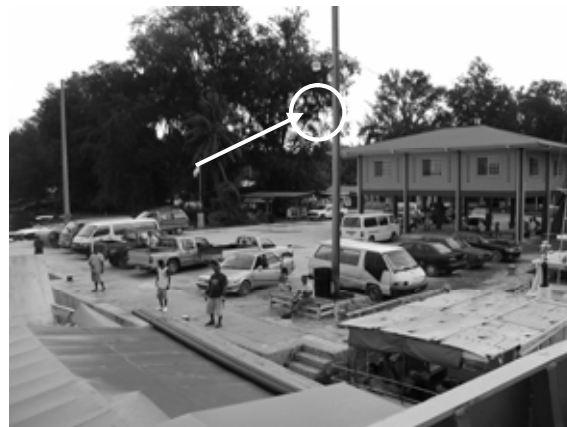
写 3.1.3(2)-10 北港の照明施設(点灯可能)
