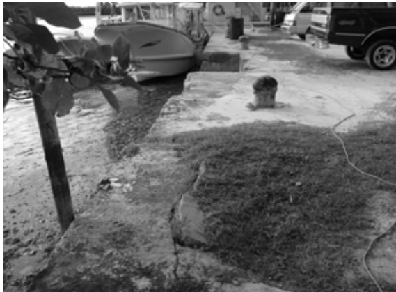
写 3.1.3(2)-3 西側物揚場上部工損傷状況 写 3.1.3(2)-4 東側護岸基礎間詰 Con 流出状況 東側護岸取付け部のコンクリートが破損し、路盤材が露出している。西側物揚場階段部分のコンクリートは風化により変形しており、使用の際の安全性に問題がある。また、係留用桁もコンクリート折損や変形、劣化が進んでいる。
