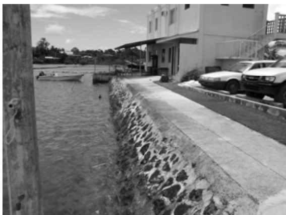
写 3.1.3(2)-23 間詰めコンクリートによる重力式傾斜護岸の例(サンゴセンター)
