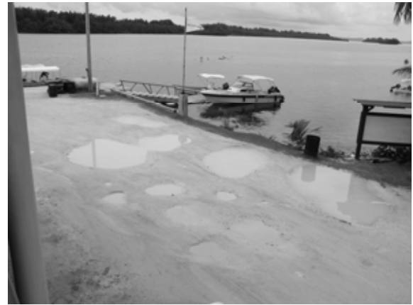
写 3.1.3(2)-9 北港東側エプロン
