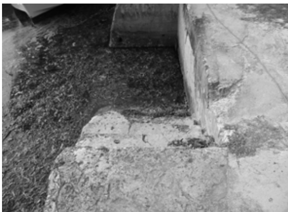
写 3.1.3(2)-5 西側物揚場階段磨耗状況 写 3.1.3(2)-6 係留桁の現状 北港西側に位置する水産施設の海側である西側護岸のガビオン(護岸構造体)は破れて中詰石材が転がり出ている。
