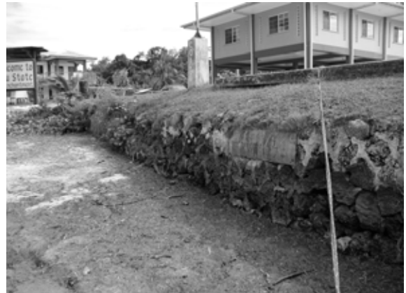
写 3.1.3(2)-3 西側物揚場上部工損傷状況 写 3.1.3(2)-4 東側護岸基礎間詰 Con 流出状況 東側護岸取付け部のコンクリートが破損し、路盤材が露出している。西側物揚場階段部分のコンクリートは風化により変形しており、使用の際の安全性に問題がある。また、係留用桁もコンクリート折損や変形、劣化が進んでいる。
