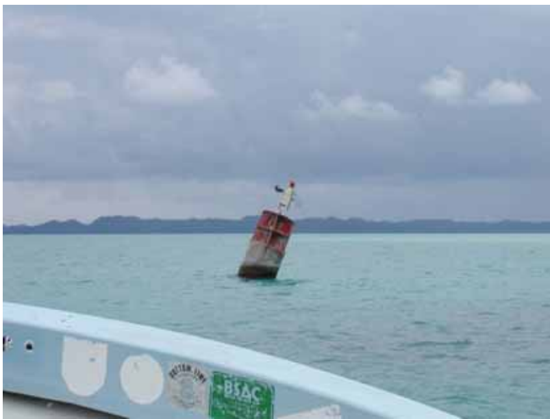
航路標識（入口部） 昼間
