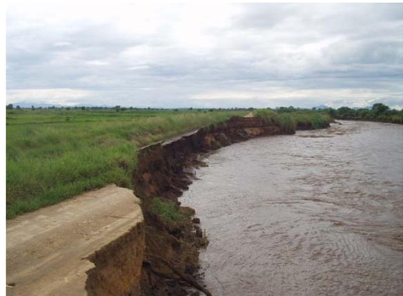
10. 2003年2月の洪水による被災直後の幹線水路
