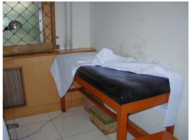
診察台（マットの部分が変形している）
