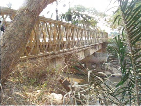
上流側橋台より望む破壊された桁の上のベイリー橋。橋の周辺一帯が地雷原のため立ち入れる箇所が限定される。
