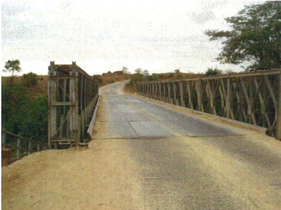
残存しているロビト側の路面より望む。ルアンダ側の崩落した桁の上に架けられた仮設のベイリー橋。幅員は4m。
