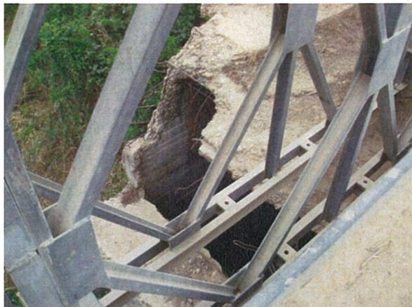
仮設橋より見たルアンダ側の橋台。桁と同時に破壊され、補修が必要な橋台。
