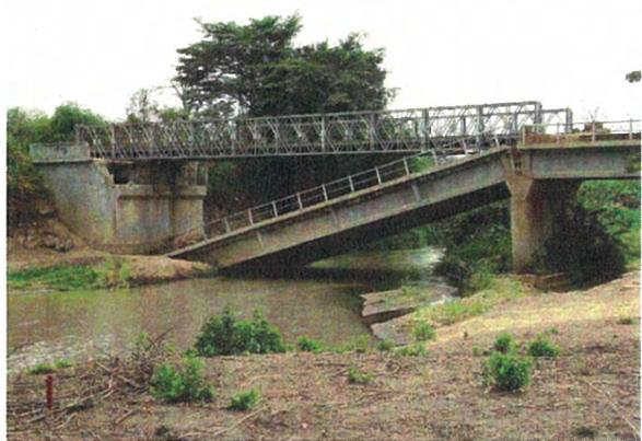
下流側川岸より望む。内戦中にダイナマイトにより破壊され崩落したルアンダ側の桁とその上のベイリー橋。
