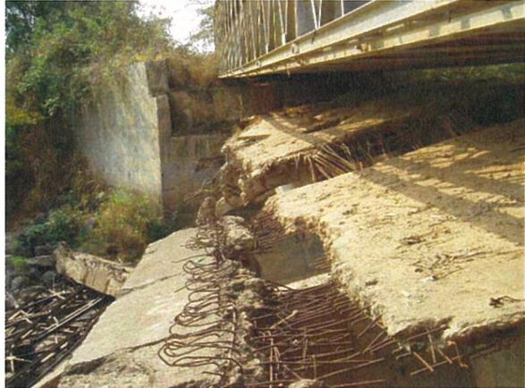
桁の上より見た要請書によると UNITA により地雷で破壊されたが崩落はしていない桁。
