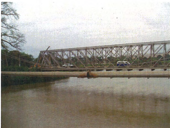
鉄道橋より望む。100年前に建設された鋼トラス道路橋とその手前の農業用水管橋。
