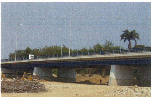
ベンゲラ市直近北側のカバコ川に架かる橋梁を上流側より望む。自国の資金により建設された2005年に供用開始した橋長172mの合成桁橋。
