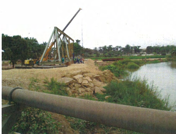
道路橋より望む。ブラジル業者 ORDEBRECHT によるトラスの組み立て作業中の水道橋。
