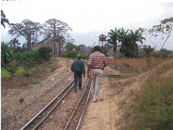
ロビト側鉄道橋上。地雷残置の可能性があるため、状況が曖昧な区域では現場警備警官の先導で現地視察を実施。
