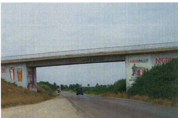
ベンゲラ市直近北側のカバコ川に架かる橋梁を上流側より望む。自国の資金により建設された2005年に供用開始した橋長172mの合成桁橋。
