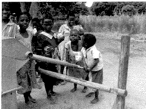
写真-23 パイロットで建設した井戸 (Machinga)
