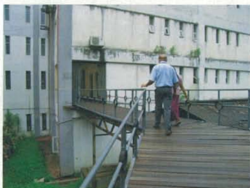
施設の妻壁 本校舎敷地側から2階の廊下へ接続するブリッジ
