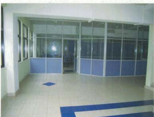
2階：情報通信分野で利用する部屋の入口付近 3年前に施設整備済みで、ほとんど現状のまま利用可能
