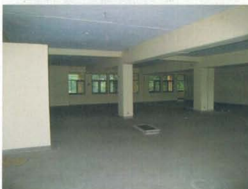
2階：メカトロニクス(2) 壁、床、天井の仕上げ状態がよい
