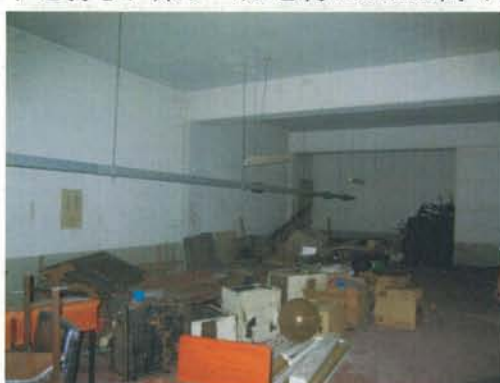
1階：メカトロニクス(3) 照明器具や天井扇等の増設が必要
