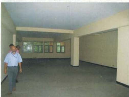
2階：メカトロニクス(1) 壁、床、天井の仕上げ状態がよい
