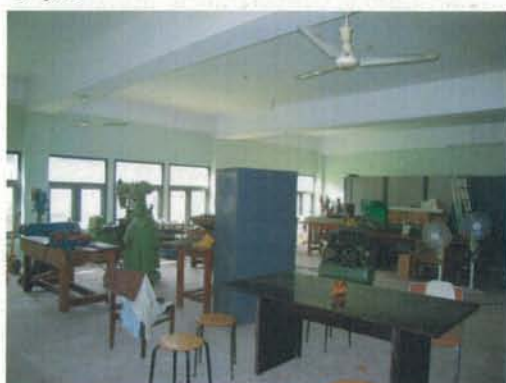
1階：メカトロニクス(1)、(2) 床、壁、天井の仕上げ状態がよい 現在、DTETのメンテナンス部門が使用
