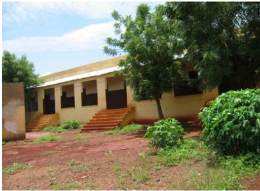
教室棟の全景
