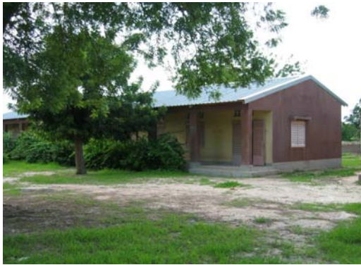
教室棟の全景 (維持管理状態が良い)
