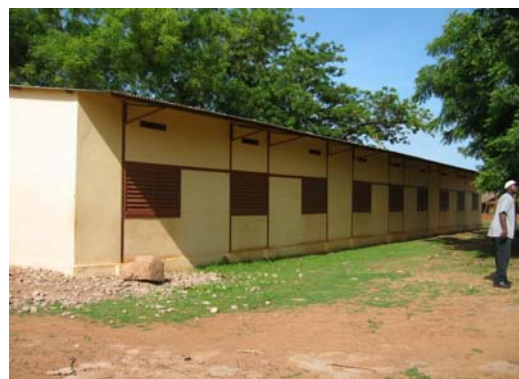
隣接する教室棟 (1年前に政府により改修)
