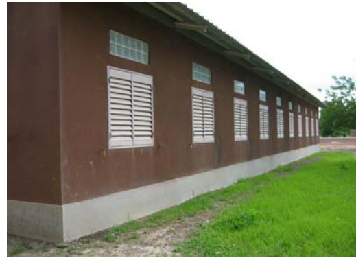
教室棟の背面 (外壁や窓の損傷なし)
