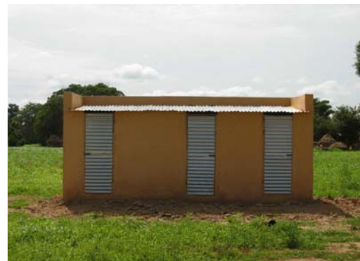
トイレ外観 (木枠に波板垂鉛メッキ鋼板張りの扉)
