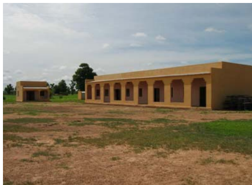
教室棟の全景 (左側が校長室棟)
