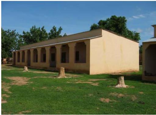
教室棟の全景
