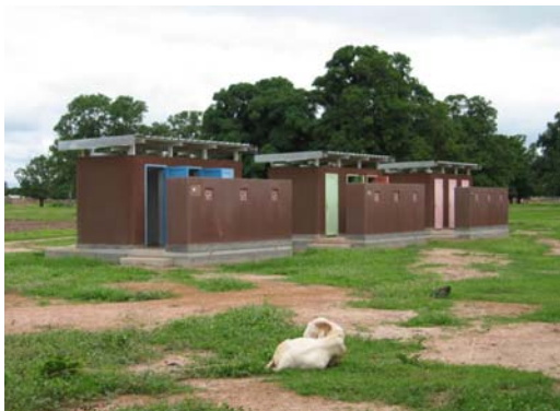
トイレ外観 (色分けされた扉)
