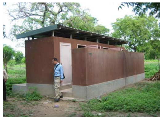
トイレ外観 (6ブース、きれいに使用されている)
