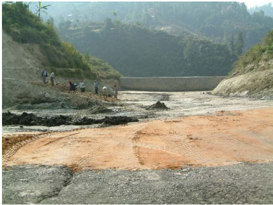
C-2: シスドル短期処分場改善(しゃ水工 (粘土層)工事) (2004年11月)
