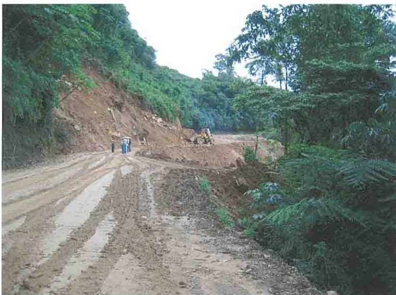
「地点3-11」 起点コタパタ 154.5km地点 (カラナヴィより 43.5km) 応急的防災工事実施中
