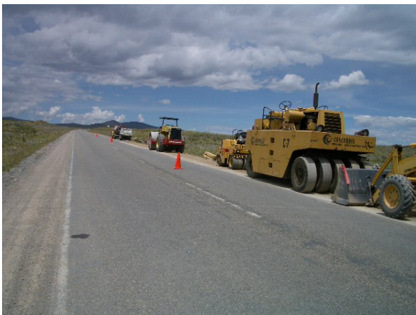
SNC 定期的維持管理スキームによる路肩補修工事 (国道2号線)
