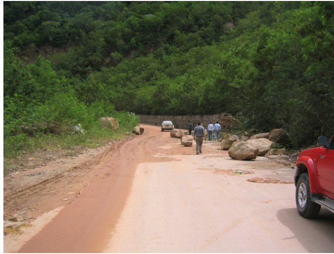
「地点 7-3」 コチャバンバより 429.8km (エルトルノより 37.1km) 落石 (最大 2.5m) 多し。前夜の豪雨による。
