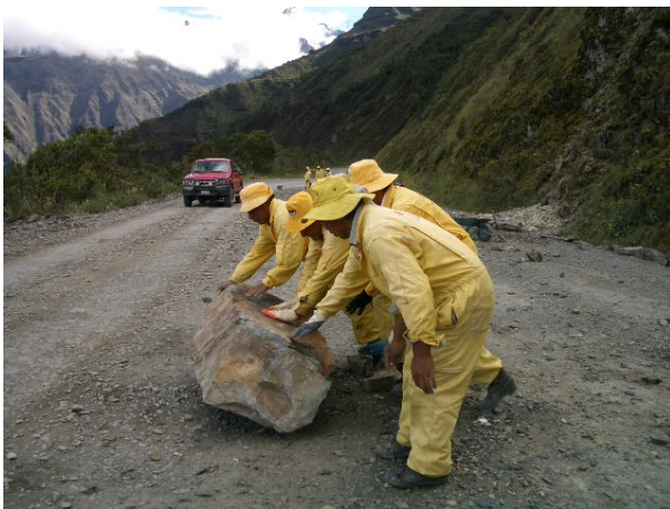
PROVIAL の零細企業による恒常的維持管理作業 2 (落石撤去)
