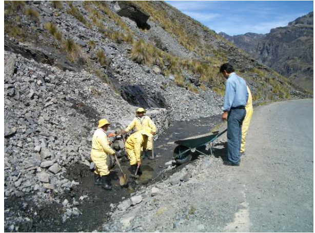
PROVIAL の零細企業による恒常的維持管理作業 1 (側溝清掃)
