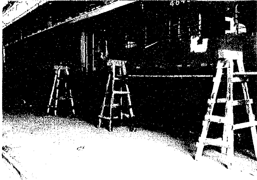
固定足場使用の人手による車体塗装作業
