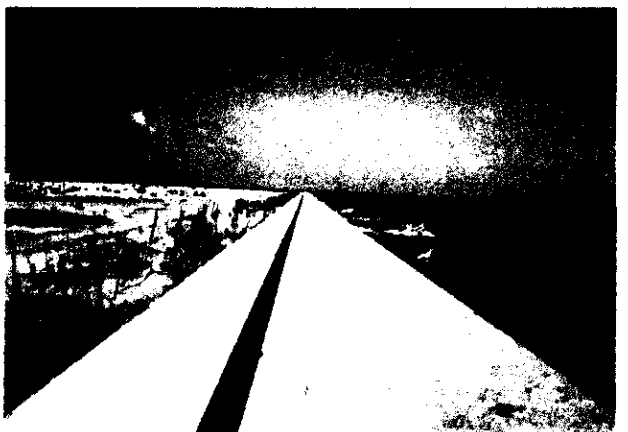
要請サイト (西岸の防潮堤)
