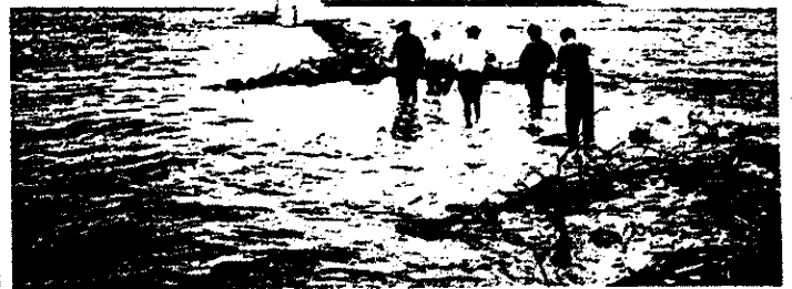
Laamu 環礁マーメンドー島棧橋
