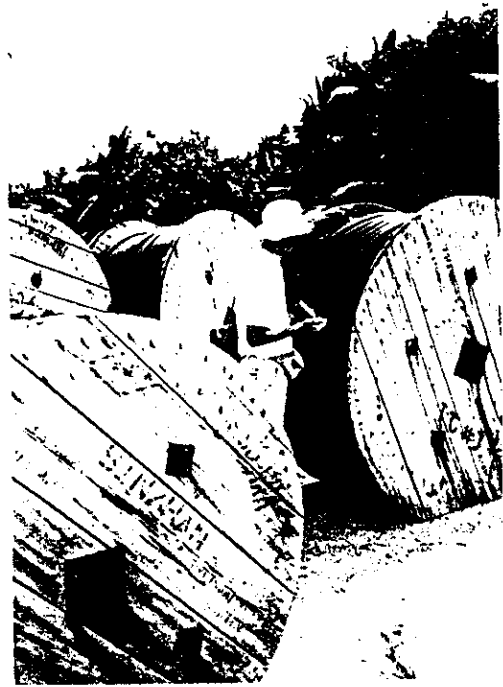
Gnaviyani 環礁フォアムラ島 MEB送電ケーブル線
