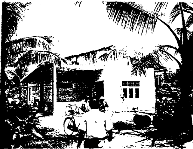
Gnaviyani 環礁フォアマラ島 MEB発電所新築建屋
