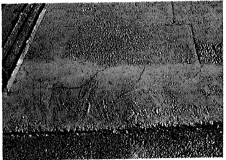
セメント・コンクリート舗装打設現場 (施工直後からクラックがあり)
