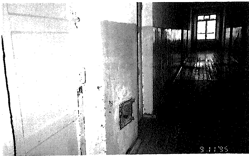
中央県ブレン町ボランガ村初等学校内の暖房設備
