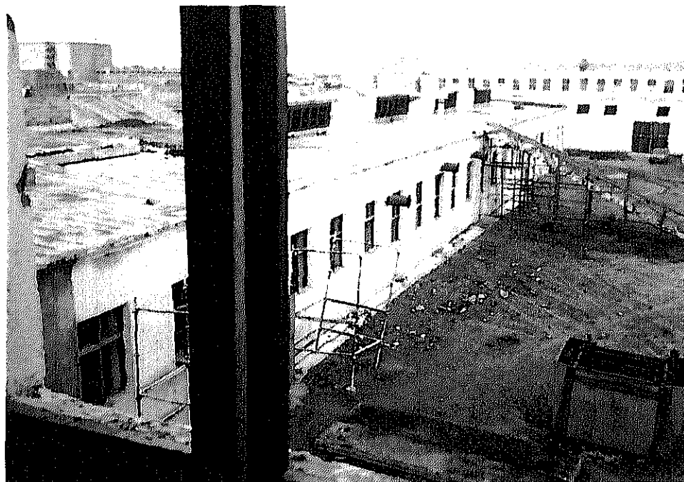
(新設) 教育設備機器・修理工場の建設現場
