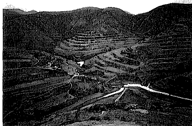
世界銀行のプロジェクトサイト。大小のテラスを造成している。
