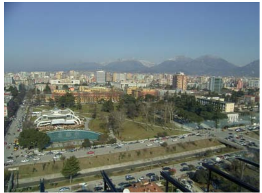
ティラナ市遠景（手前が整備済みのラナ川）
