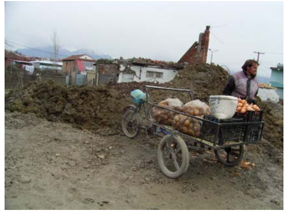
ティラナ・Durres 間道路拡幅工事による家屋の撤去
