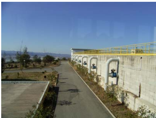
Bovilla 浄水場（左側は貯水槽）
