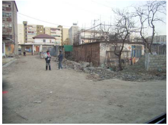
ティラナ市内車道及び歩道改修中
