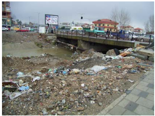
ラナ川中流部整備未完了地区（橋より下流は未整備）
