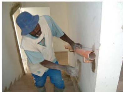
4.階段手摺取付け工事
