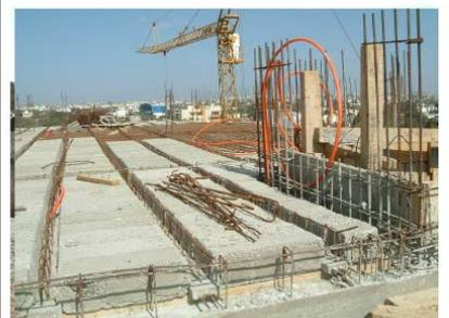
5.最上階ウルヂイ型枠施工中
