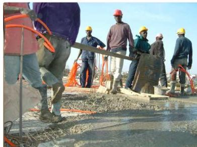
4.最上階屋根スラブコンクリート打設中
