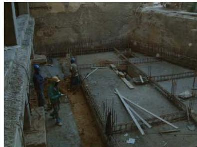
3.地階の床梁の鉄筋配筋施工中
