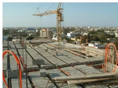
5.最上階ウルヂイ型枠施工中
