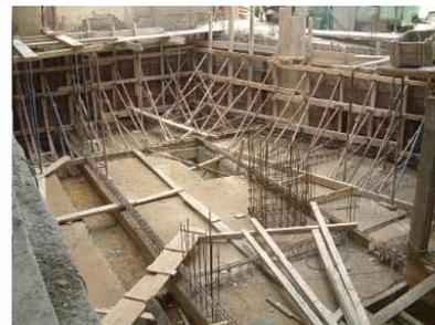
3.地階外壁型枠工事中
