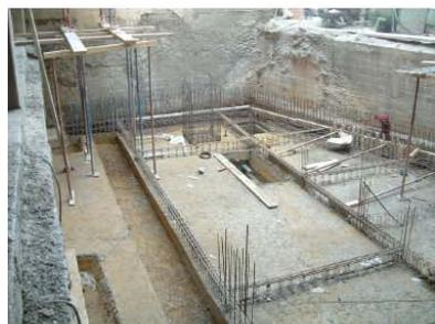
3.地階の床梁の鉄筋配筋施工中
