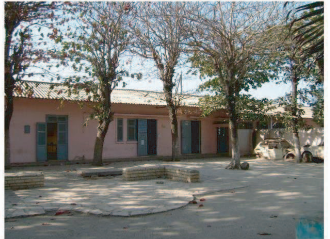
人事院庁舎を間借りしている現EFIダカール校の外観
