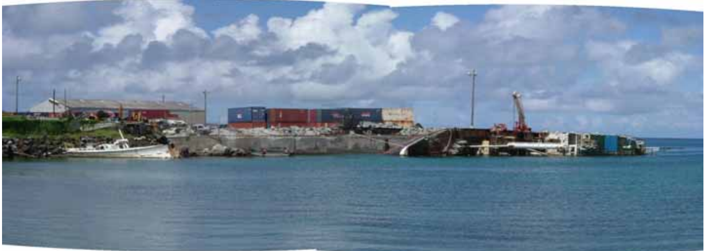
C 岸壁全景。左は魚船沈船、右マイクロ・ドーン。岸壁全体に B 岸壁エプロンのコンクリート廃材。
