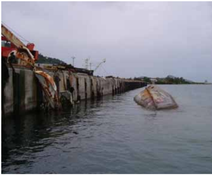
拡張B岸壁、上部工・防舷材損傷状況。
