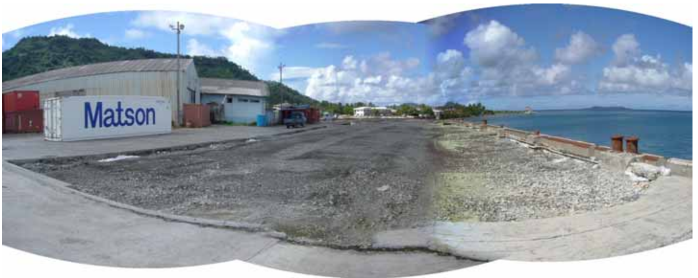
B 岸壁エプロン開削状況、2005 年 4～5 月実施。
