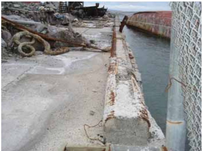
C岸壁車止の損傷状況。
