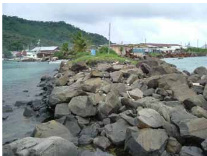
波除堤先端部捨石の状況。
