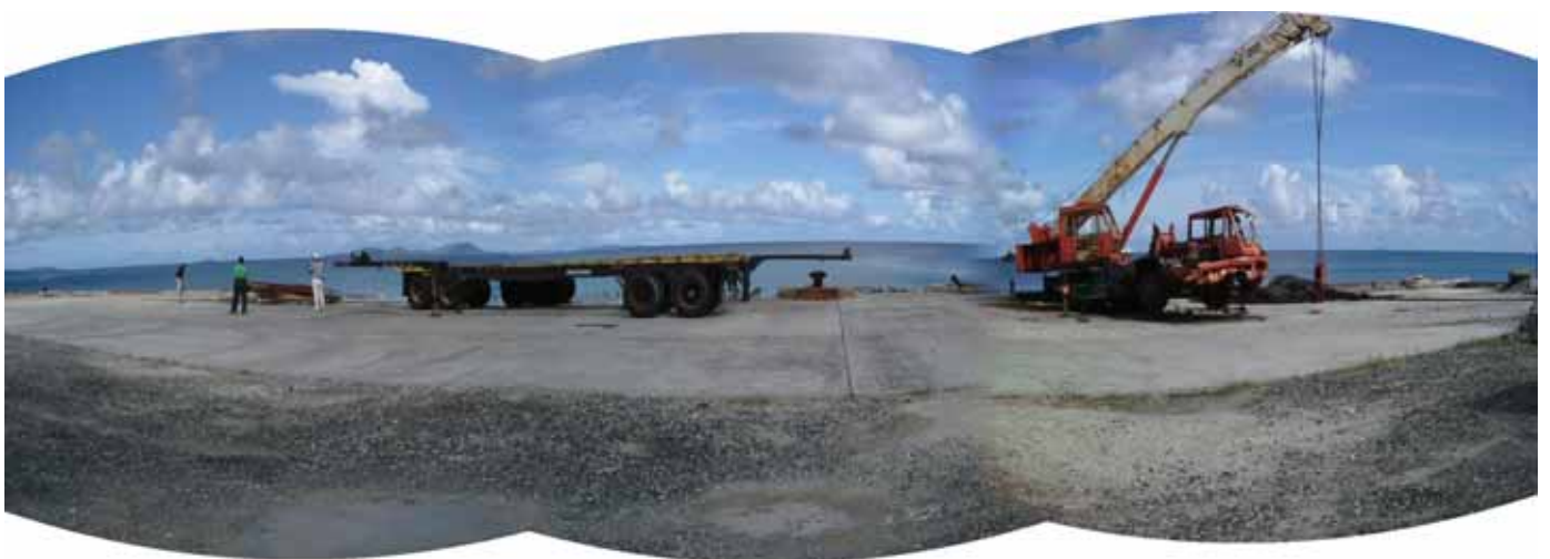
拡張 B 岸壁、エプロン全景、廃棄トラッククレーン・トレーラー荷台前面に沈船。
