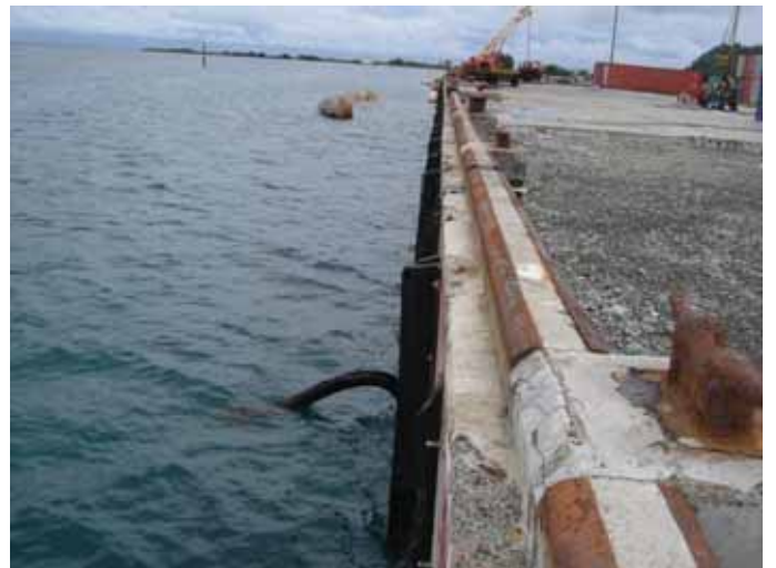
旧B岸壁、上部工・防舷材損傷状況。
