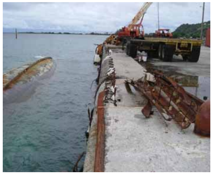
拡張B岸壁、上部工・車止の損傷状況。
