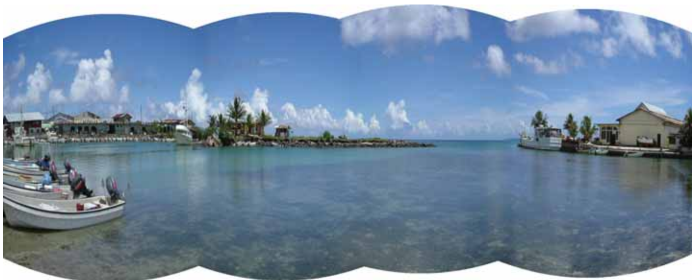
南岸壁から港内進入路を望む。進入港口幅は約80m、右側はアイザワススム埋立地。
