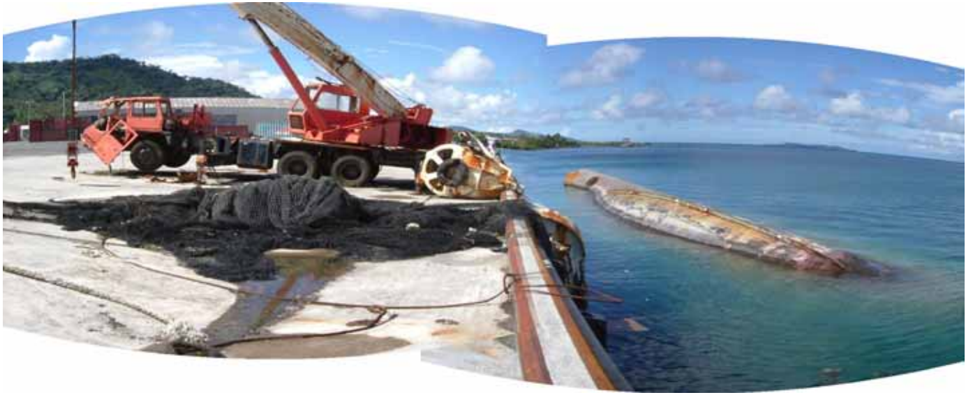
拡張 B 岸壁前面の沈船、チューク州所有漁業調査船。
