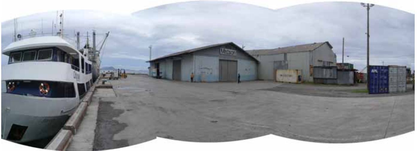
A 岸壁及び倉庫 2 棟、倉庫内部にトランスコ事務所。
