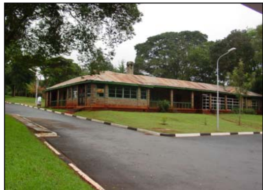
BLOCK-A(事務棟) 本計画実施に伴い撤去される予定。
