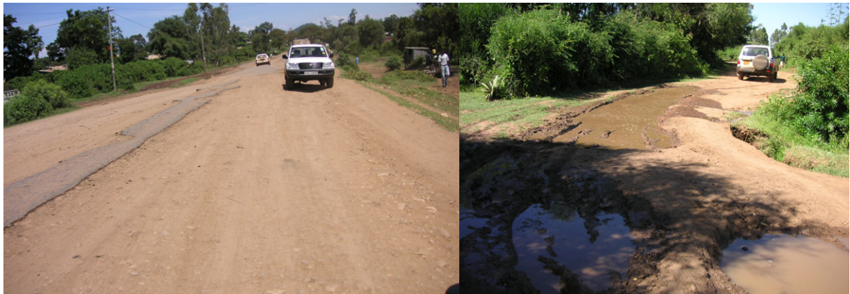
写真：ホマベイトウン内の幹線舗装道路と地方未舗装道路の状況
