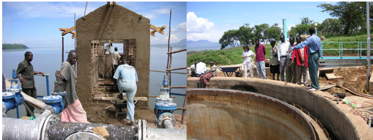
写真：ホマベイトウン取水場改修工事と下水処理場リハビリ工事の状況
