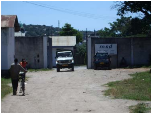
ムワンザ州 MSD地方倉庫 入口
