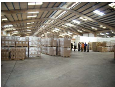
2004年に新築されたMSDの倉庫 内部
