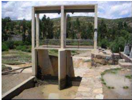
写真-2 土砂吐および取水施設
