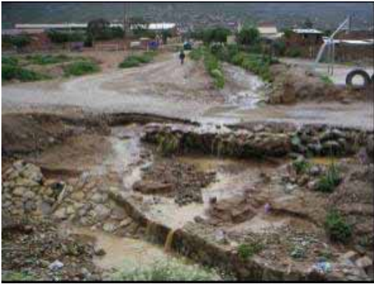
写真-5 土砂流入状況
