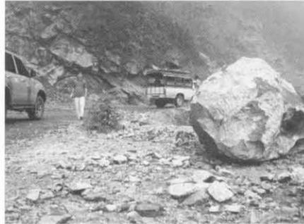
斜面崩壊による落石
