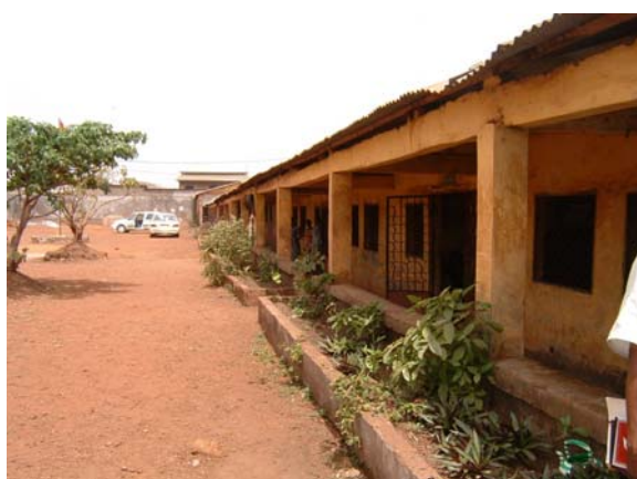
コナクリ・マト区、Cite de l'air (既存教室棟廊下側外観、1976年建設)
