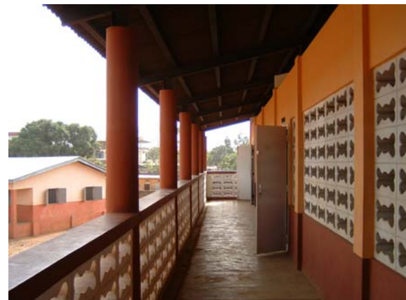
コナクリ、ラトマ区、Kaproo校(三次) (2階建既存教室棟、2階外部廊下)
