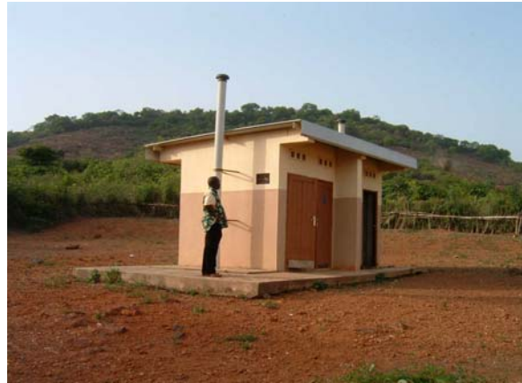
マムー県、EP Pettiny校(第一次) (便所棟外観)
