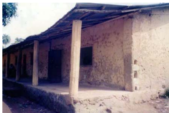
写真 4-1 バンコ造の教育施設
