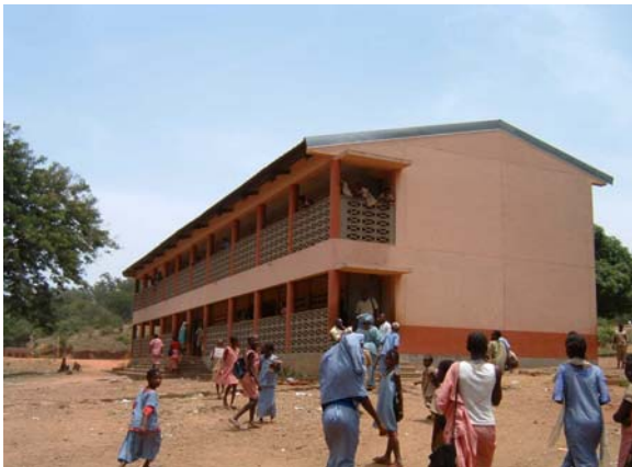
キンディア県、Tafory校(第二次) (2階建既存教室棟外観)
