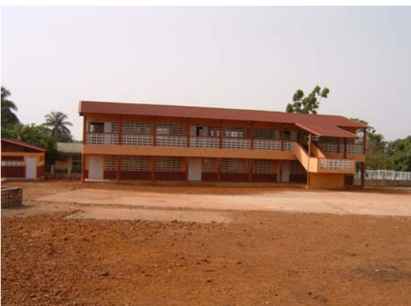
コナクリ、ラトマ区、Kaproo校(三次) (2階建既存教室棟外観)
