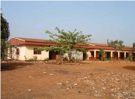
コナクリ・ラトマ区、College Koloma (中学校での増設要請、既存教室棟3棟のうちの1棟外観、1992年建設)
