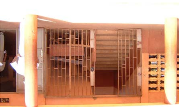
ラベ県、Bowouloko校(第二次) (教室棟、学校により設置された階段室入口部 防犯用鉄扉)
