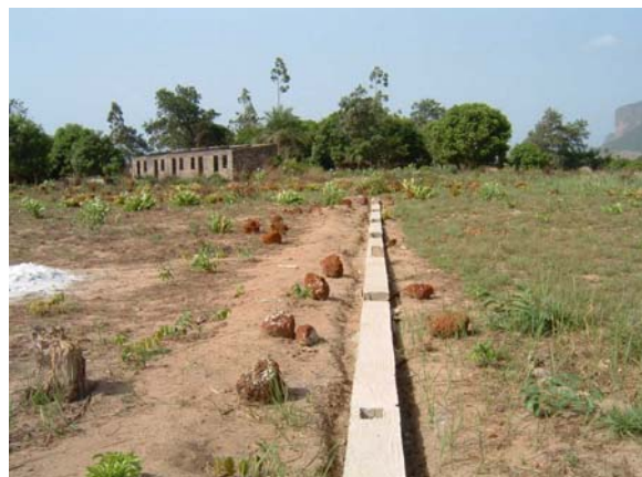
デュブレカ県、Kagbelen Plateau (敷地内に既存囲壁基礎などの障害物あり)
