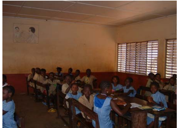
コナクリ、ラトマ区、Kporo校(二次) (既存教室棟内部、施工品質に不都合なし)
