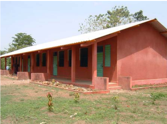
コヤ県、Kassaf小学校 (Kfwiにより建設、既存教室棟外観)
