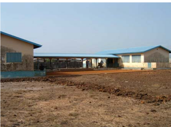
デュブレカ県、小学校 (Fondation International Solidariteにより2002年建設、既存平屋教室棟外観)
