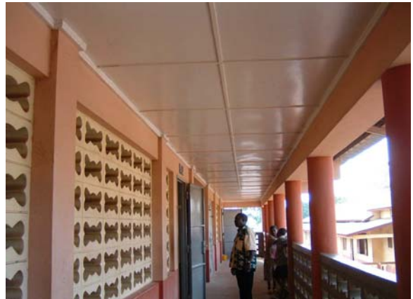
マムー県、EP Centre 1校(第二次) (2階建既存教室棟、2階外部廊下、施工 品質に不都合なし)
