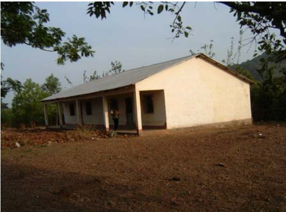
マムー県、EP Pettiny校 (住民参加により建設された既存教室棟)
