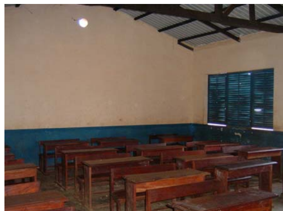
デュブレカ県、小学校 (既存教室内部、天井なし、状態は良好)
