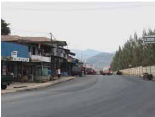
写真 1-7 港側から見た道路の全景（改良開始地点）
