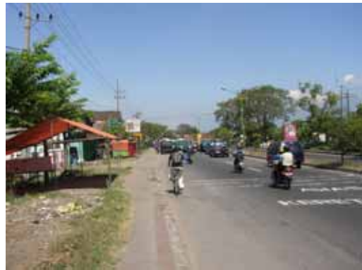
写真 6-2 道路改修開始地点から踏み切り方向全景
