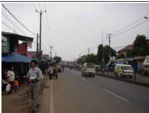
写真 2-1 セラン側より改修開始予定位置の全景
