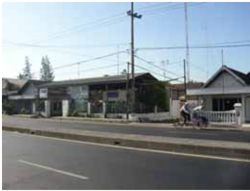
写真 5-1 移転予定家屋 (改修開始地点)
