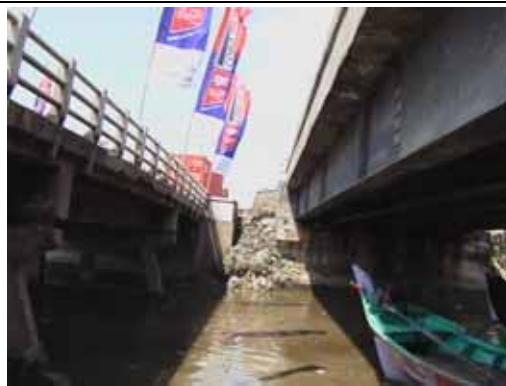
写真 4-4 河川横断橋梁の下部
