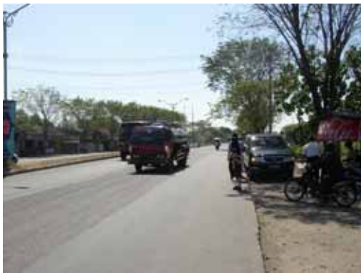
写真 6-7 道路改修開始地点での道路全景
