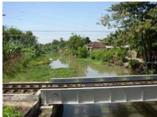
写真 6-8 改修予定道路を横断する排水路
