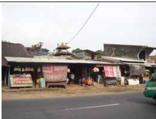
写真 3-3 移転予定の建物
