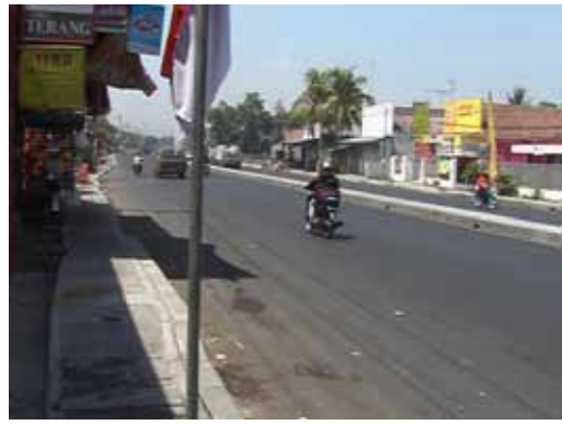
写真 5-2 拡幅事業が完了した道路全景 (狭い歩道)
