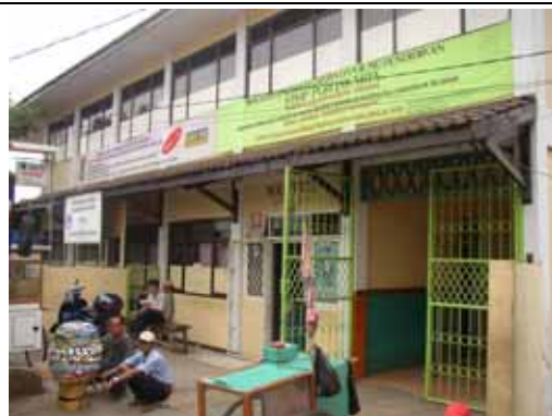
写真 2-8 建物を移設予定の高校
