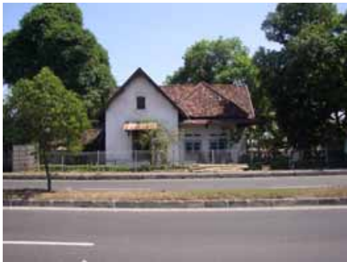
写真 6-1 道路改修開始地点での移転予定家屋
