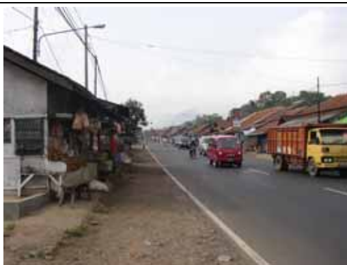
写真 3-1 鉄道交差部より改良予定道路の全景
