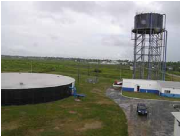
ローズホールの浄水施設の敷地内にある地上型配水池と高架タンク。コリバートンについても同様の施設が要請されている。
