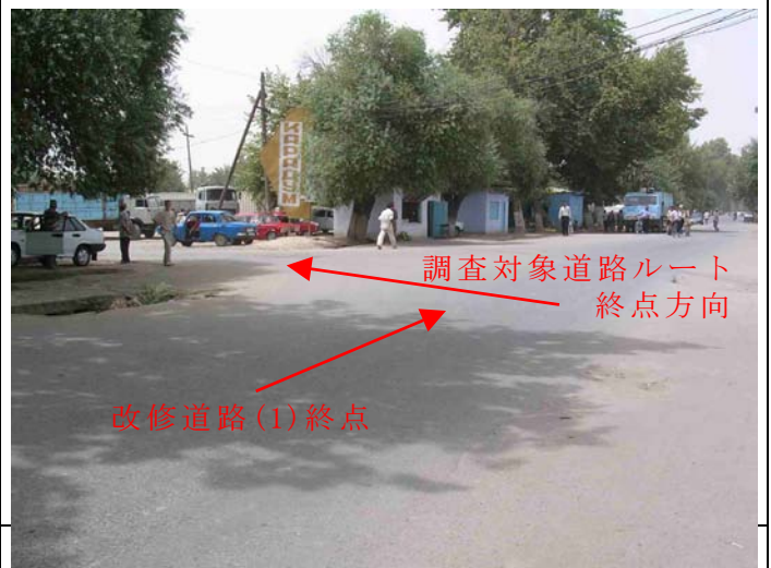
調査対象案件の道路と交差する箇所である。
