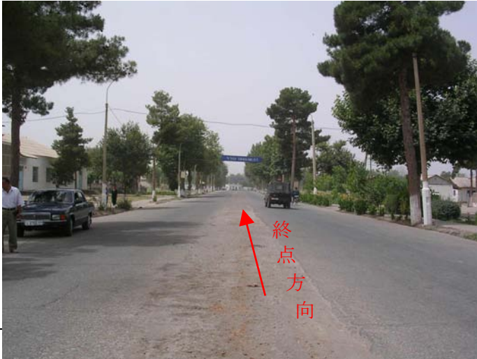
車道中心付近の舗装面が完全に剥離している。
