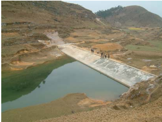
生態農業で建設された農業用水ダム（2004年3月）
