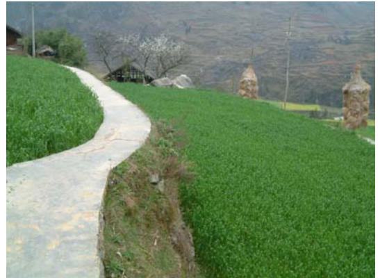
セメント補修した農道（2004年12月）
