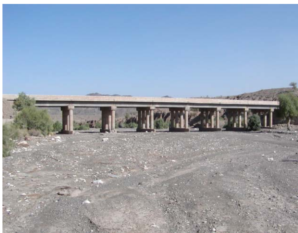
9 径間 RC 桁橋
