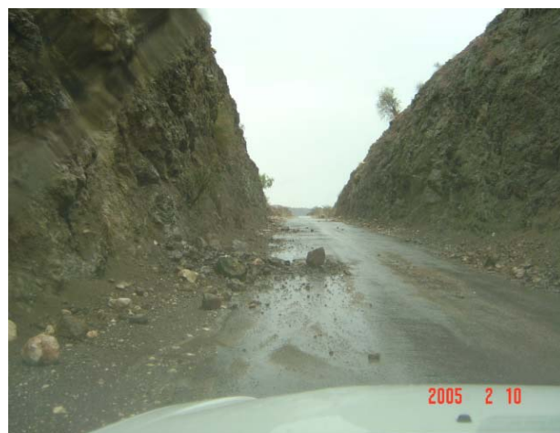
降雨後の落石
