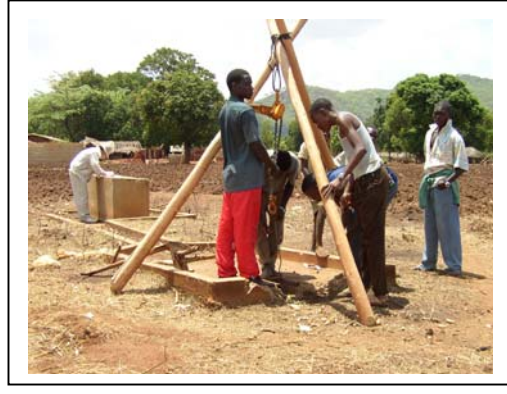
写真 3-2 チェーンブロックでの引上作業
