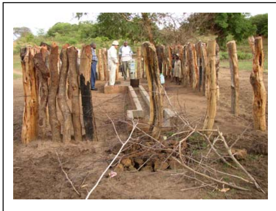
写真 3-19 日本が建設した井戸 (70mまで掘削した)。
