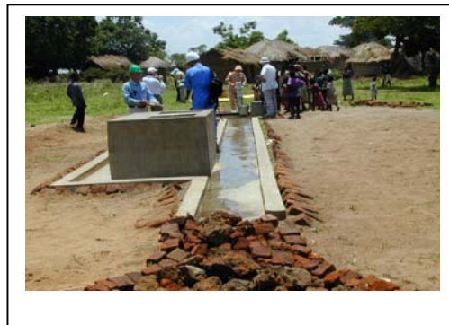
写真 3-8 完成直後の付帯施設
