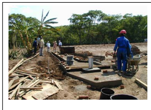
写真 3-10 工事中の付帯施設
