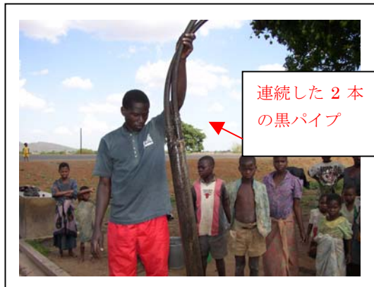
写真 3-4 引き上げられた揚水管
