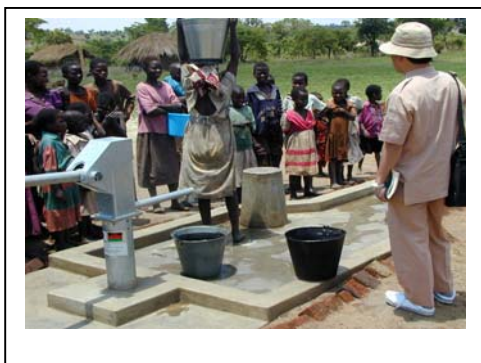
写真 3-9 日本が建設した井戸と付帯施設
