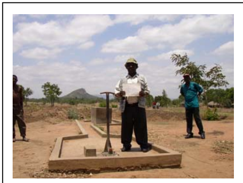
写真 3-7 足踏みポンプと付帯施設
