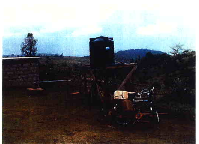
中国の援助で建設された貯水タンク（ケニア）
