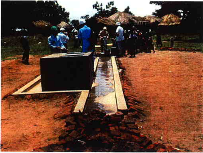
日本の無償で建設された直後の井戸（2002年12月）（マラウイ）
