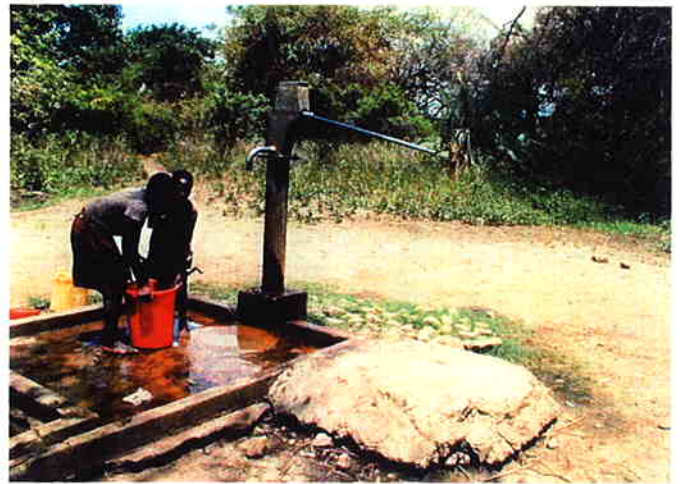
1992年の日本の無償で建設された井戸 日本製のハンドポンプが現在も稼働している。(ザンビア)
