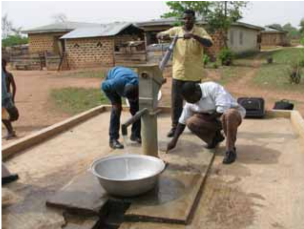
Brong Ahafo 州 Jaman 郡 Konsia 村の日本無償井戸施設。1994年に設置された。スペアパーツが入手できず2年間使用されなかったが、2005年1月から使用再開。
