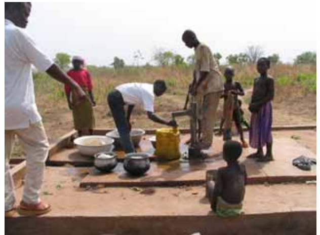
Northern 州 Nanumba 郡 Kabliya 村の日本無償井戸施設。Nira ポンプが設置。水量豊富。
