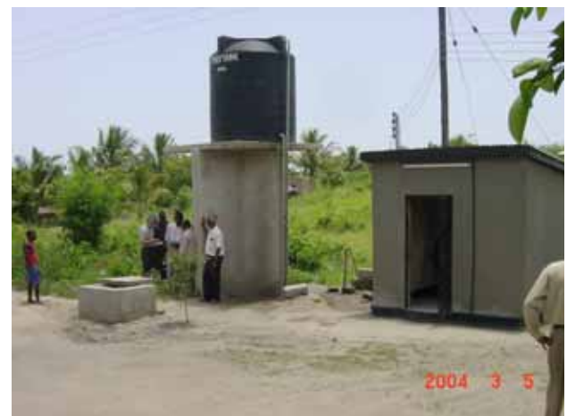
ダルエスサラーム州キノンドニ市マダリ村の水中ポンプ付き深井戸、キノンドニ市役所建設、水価は1Tsh/lit
