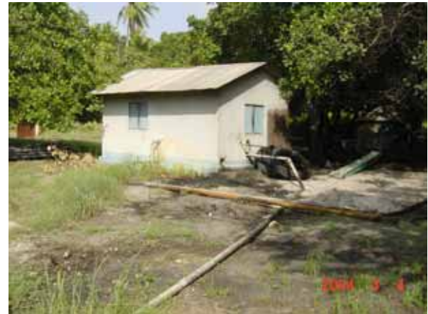
左の井戸の送水ポンプ小屋、ムクランガタウンの下の写真の給水塔まで送水する予定であった
