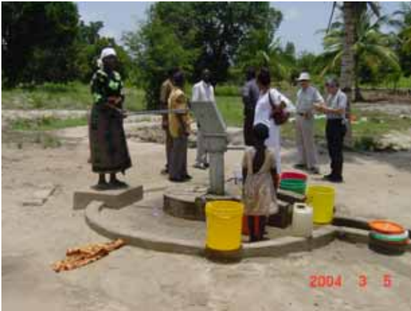
ダルエスサラーム州キノンドニ市ムボボ村の手掘り浅井戸、保護してハンドポンプを取り付けている、NGOが建設、料金は0.5Tsh/lit
