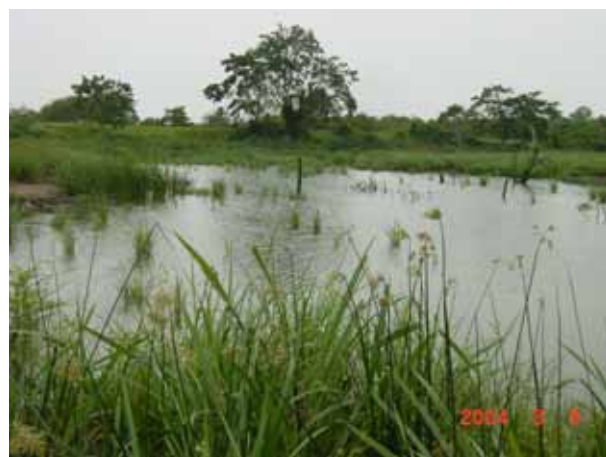
コースト州バガモヨ県ビル村の決壊したマングラダム貯水池と堤体、生活用水と家畜揚水として利用されていた
