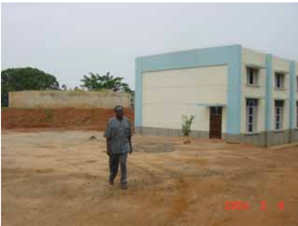
浄水場の南側にあるブースターポンプステーション、左が配水池、6基のブースターポンプが稼働
