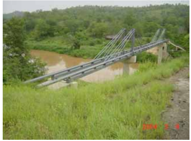
浄水場からワミ川を渡す水管橋、2本の送水管が渡されている
