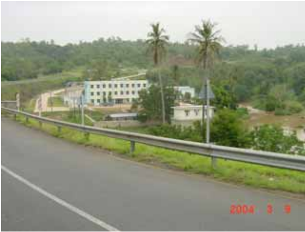
中国の無償資金援助で建設されたチャリンゼ管路給水システムの、ワミ川からの取水施設、浄水場、ポンプステーション
