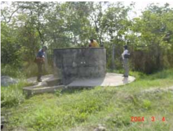
コースト州ムクランガタウンの水源である大口径浅井戸、深度3m程度、現在は水位が低下し使用不能となっている
