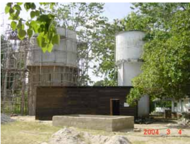
ムクランガタウンで建設中の給水タンク、容量40m 3
