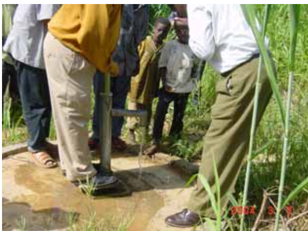
コースト州キバハ県ワタ村にあるハンドポンプ付き井戸、NGOが建設、井戸の深さは4m、水委員会が設立されており、料金は0.5Tsh/lit
