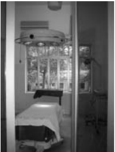
手術室 （外気が流入し、清浄度が確保されていない）（ベッド間隔狭く、清浄度確保されていない）
