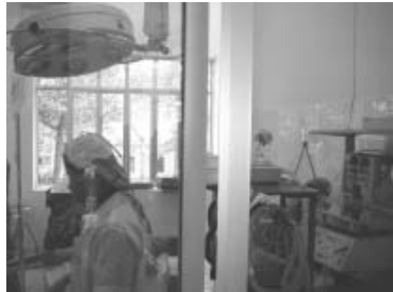
一般外科手術室 （無影灯が老朽化しているため照度不足）
