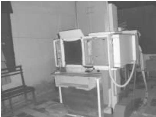
レントゲン室 （危険な状態で使用中のX線透視撮影装置）
