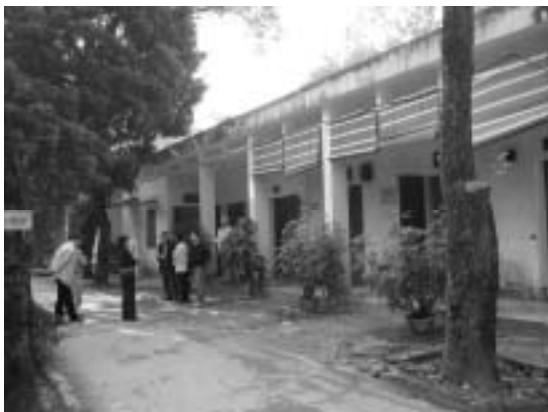
管理棟（外観） （敷地内に分散配置された管理部門）
