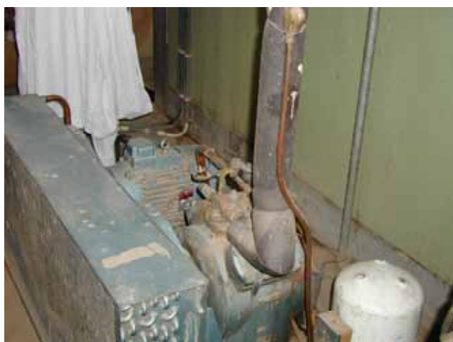
写真-29 パウチ地域冷蔵倉庫の冷凍室用発電機 (KVA不明)。古いが使用可能である。
