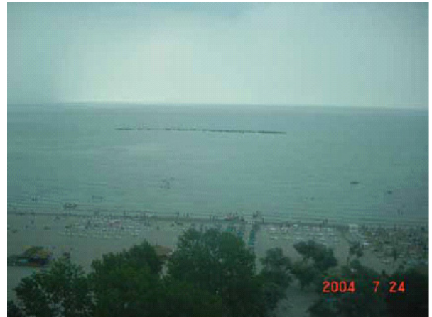
写真-4 Mamaia 海岸の離岸堤
