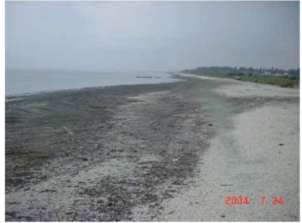
写真-2 Midia 港の南防波堤(長さ約 5km)の南側の付け根
