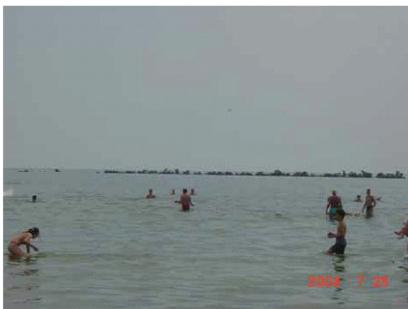
写真-5 Mamaia 海岸の離岸堤の沈下の様子
