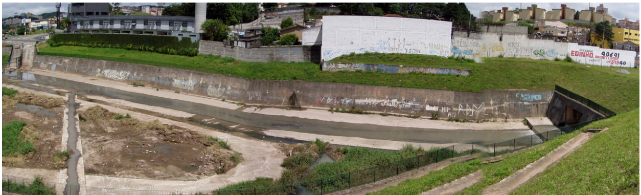
既存の雨水排水調整池 (Jd. Lavinia地区)
