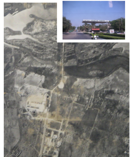
建設中の工業団地（バランキージャ）
