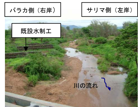
水制工の作用によって流心がサリマ側に寄っている。撮影日：2004年12月23日
