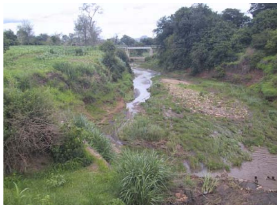
写真-12:アングニカルバート
