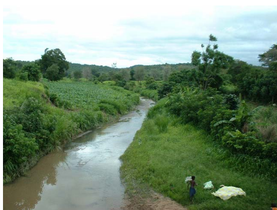
写真-11:アングニカルバート
