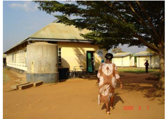
産科病棟:建物の状態は比較的良好である。 改修して管理棟として使用する予定。
