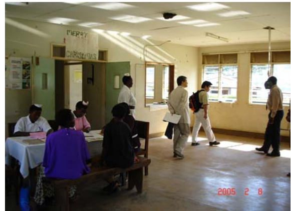
母子保健棟：劣化は他の建物より少ない。
