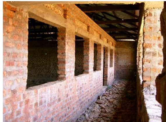
ブギリ県シグル保健センターⅢ： 建設中の建物内部
