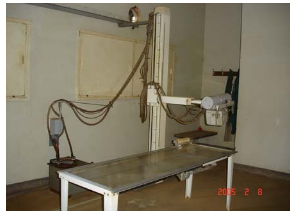
X線撮影装置：故障しておりX線撮影が行えない。
