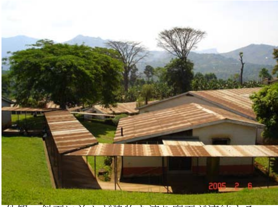
外観：斜面に並んだ建物を渡り廊下が連結する。
