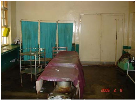
手術棟内部:衛生的な環境が確保できない。
