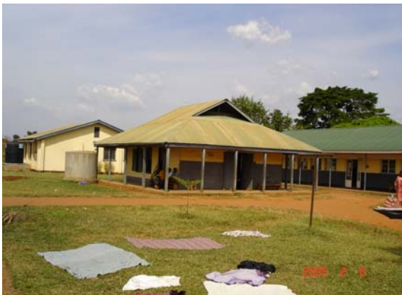
男性病棟:建物の継続利用は可能だが、総合病院の病棟としては手狭である。
