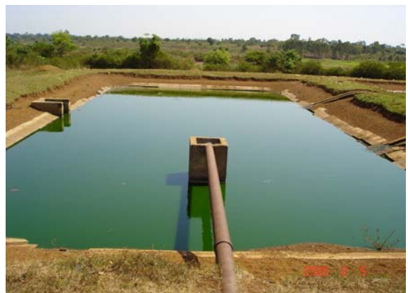
ブギリ総合病院 排水系統下流の専用ラグーン： 有効に機能している。
