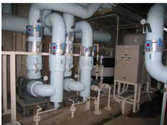
ポンプ類更新
