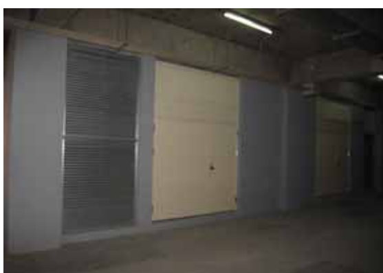
発電機室新設
