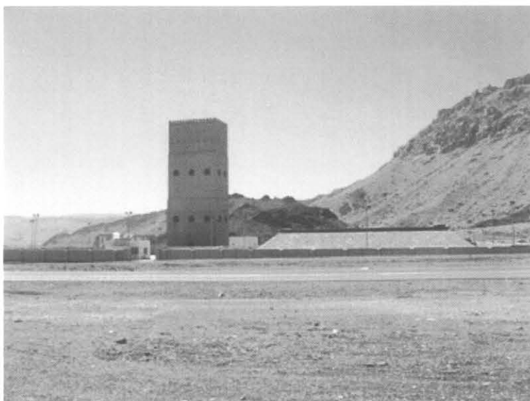
ヤンクルの給水塔と 貯留タンク（右の低い 台形の施設）
