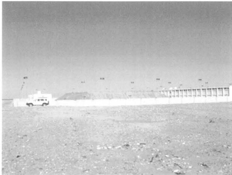
水源地の貯留タンク
