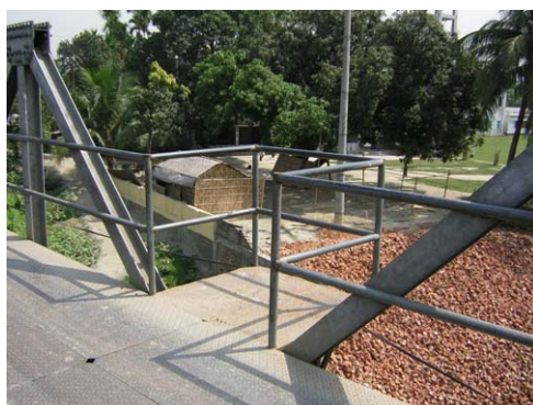
写真 3.2.2-1 「バ」国で施工された待避所 （第 1 次簡易橋プロジェクト 橋長 115m）
