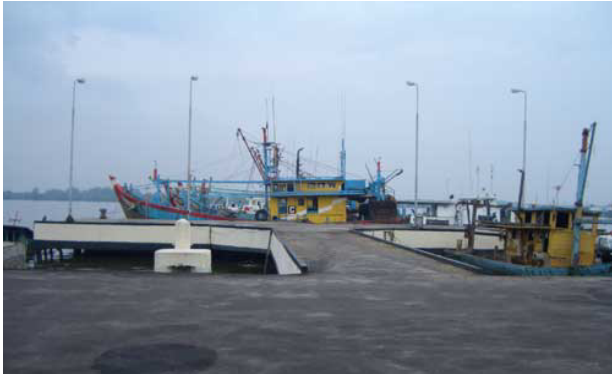
警察局構内から T 形に突き出ており、岸壁下辺の黒い線まで潮が上がる。
