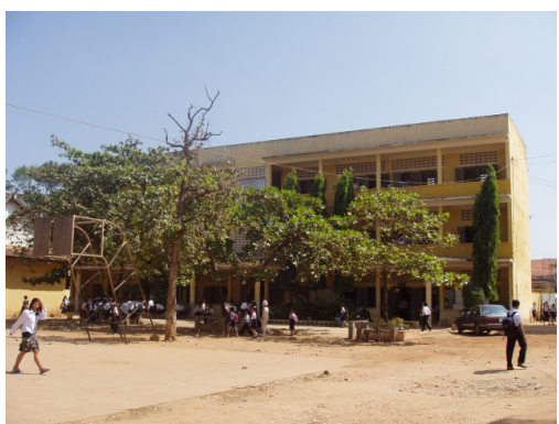
3階建の小学校校舎 全教室に照明器具付き
