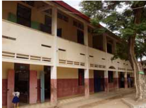
2000年にEUの支援で建設された 2階建て8教室の校舎
