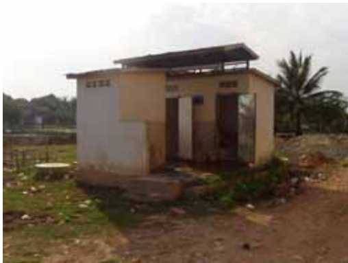
既設便所（新校舎建設位置近辺）
