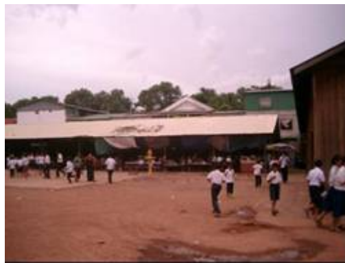
新校舎建設位置の前面に既存する 大規模な校内売店：小屋組は鉄パイ プで組み立て屋根は鉄板葺き
