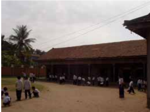
既設木造校舎 新校舎完成の後は、取り壊す予定である
