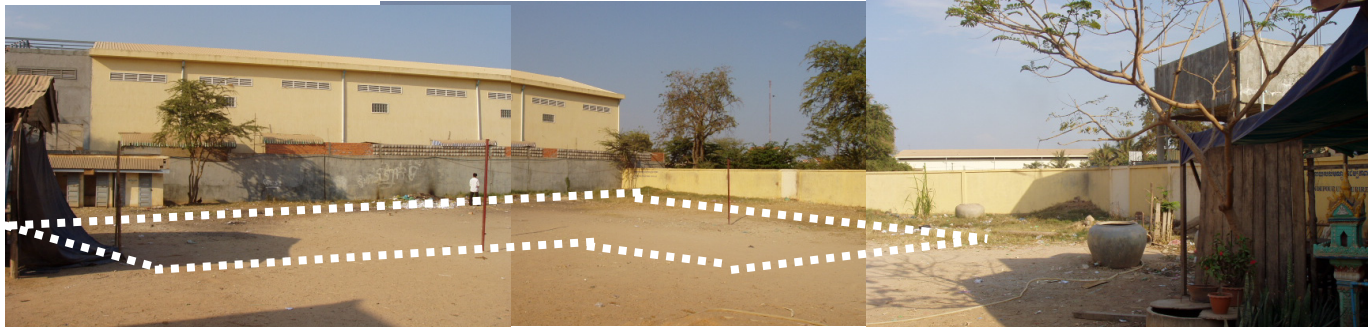
新校舎建設用地：学校敷地の北側奥に位置し、資材の搬入・搬出の困難が予測される。敷地が平面的に変形しているのでL型の校舎を建設する。
