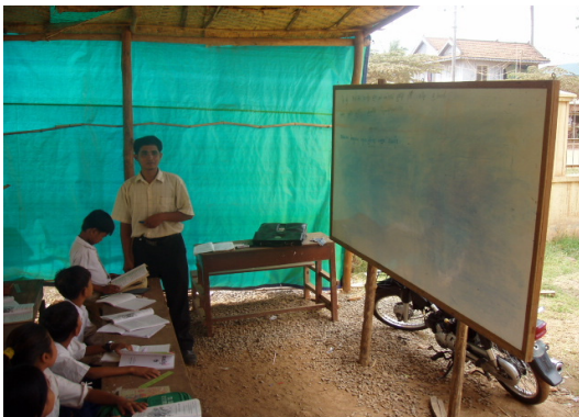
既設校舎の横に設置されたビニール張りの仮設教室
