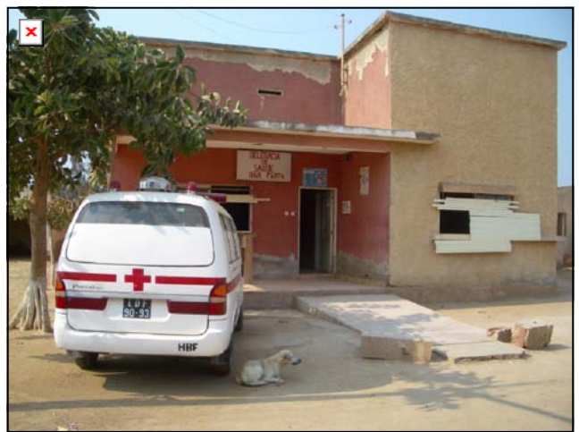
写真4 ベンゲラ州バイアファル市の保健ポスト（窓；破損し、板でカバー、壁；各所で剥離）
